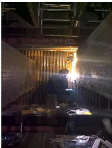
Rys. 10. Prowadzone prace spawalnicze
