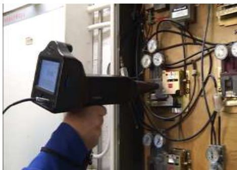
Rys. 12. Skanowanie szafy pneumatycznej [12].
