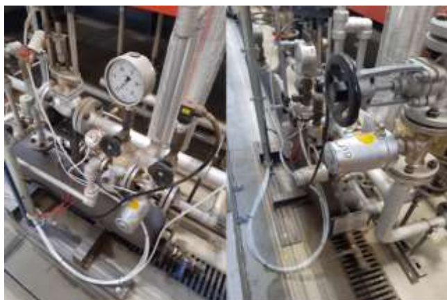
Rys. 6. Wymienniki ciepła i odwadniacze sterowane pneumatycznie [fot. T. Modrzyk].
