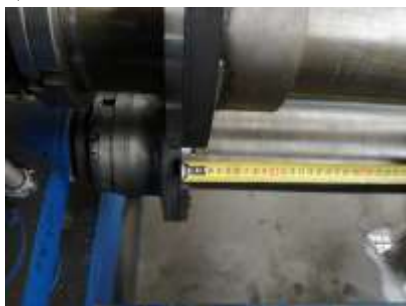
Rys. 5. Montaż noży krążkowych mocowanych w tulejach, gdzie: a) odsunięcie prawej podpory, b) montaż noży krążkowych mocowanych w tulejach, c) kontrola ustawień
